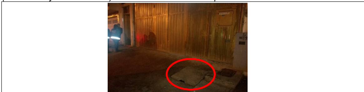
Foto No. 1. Caja de inspección externa ubicada frente al predio de la KR 13F 58 25 SUR
